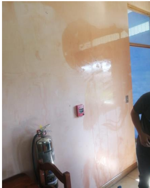
Proceso de preparación de la pared
