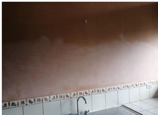
Limpieza de paredes
