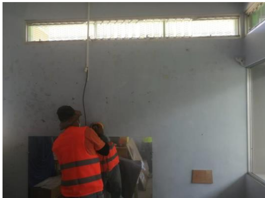
Lijado de paredes
