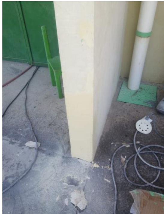
Reparación de paredes con acabado desprendido
